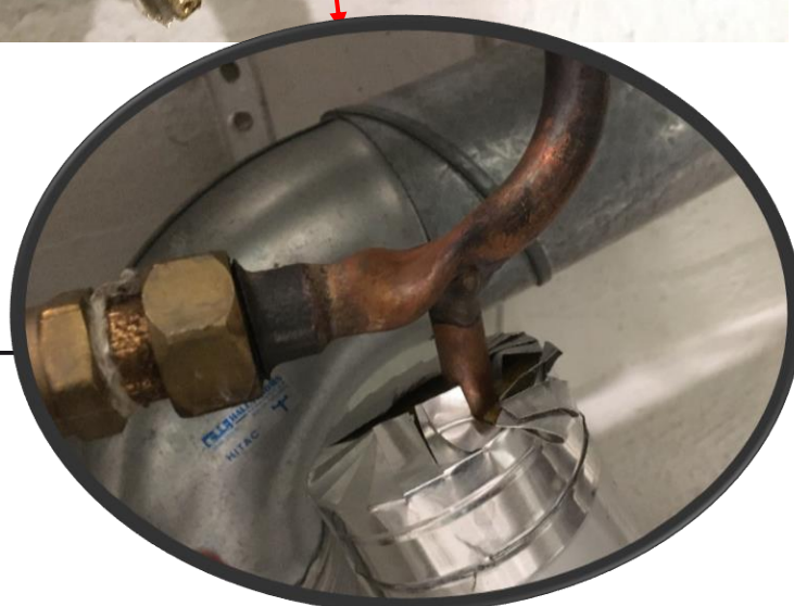
Figur 30 STAD-ventil och en STK-ventil Felaktigt installerad STAD-ventil. Utöver att det är inte tillräckligt med raksträcka framför och bakom STAD-ventilen är röret sammanpressat och ett insvetsat kopparrör nära ventilen leder till en TA-STK-ventil.
