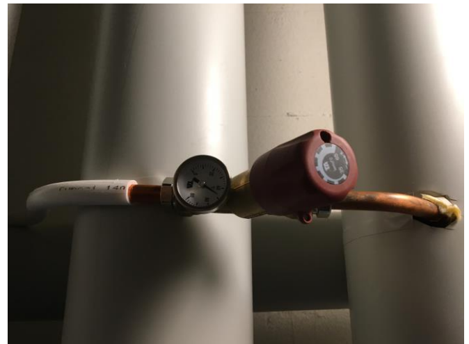
Vissa lägenheter har termiska ventiler.
