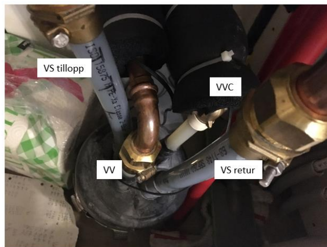
Kulvert i teknikrum i lägenhet
