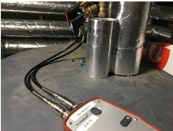
VVC-flöde kontrollerades även vid en STAD-ventil.
