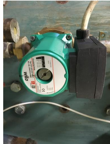
VVC-pump UC, ej tryckstyrd.
