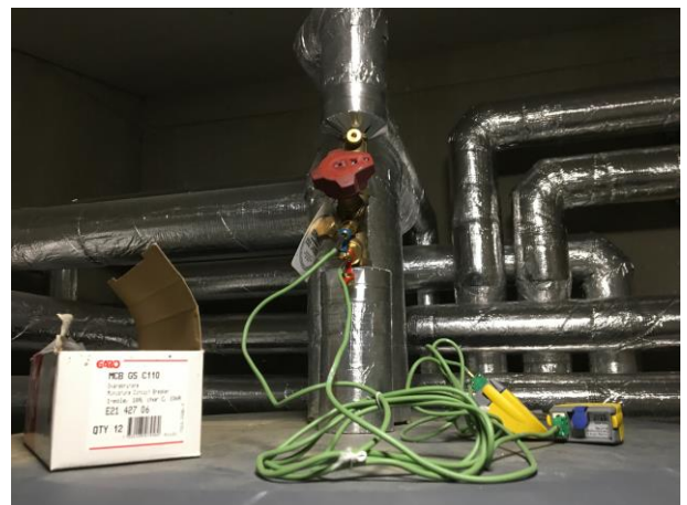
VVC-temperaturmätning via STAD-ventil.
