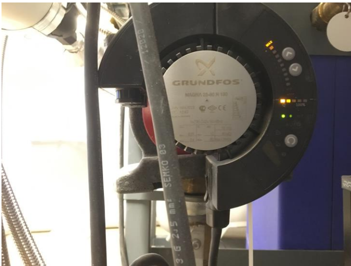
VVC-pump. Inställd för variabelt flöde.
