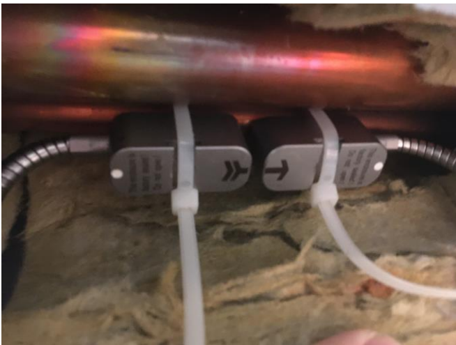
Foto av flödesloggning av en VVC-ledning.
