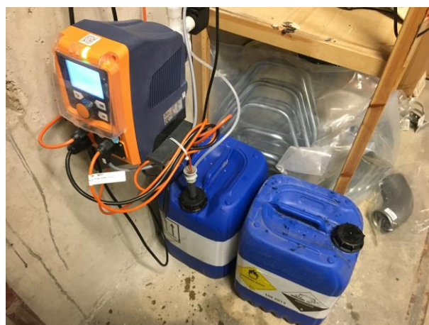
Väteperoxidanläggning för bekämpning av legionella.
