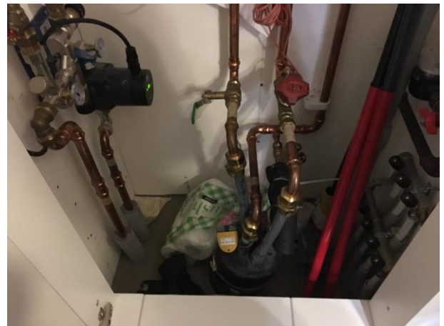
VS-pump som finns till golvvärmen, finns en per hus. Aktiv under sommaren. Tryckstyrd.
