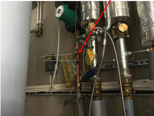
Mätning av VVC-flöde.
