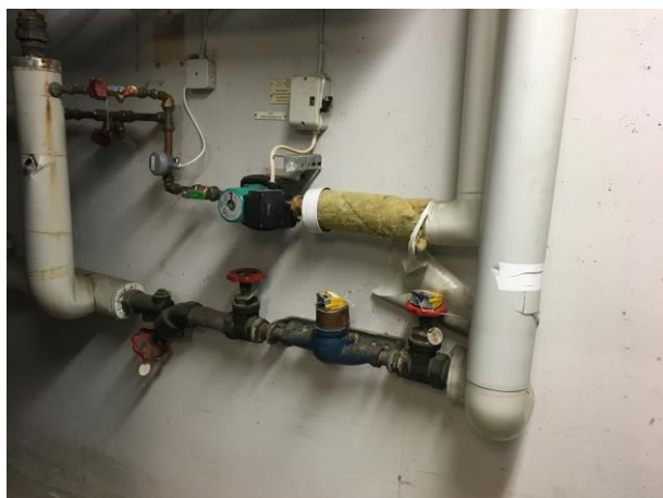
Före åtgärder med väteperoxidanläggning.
