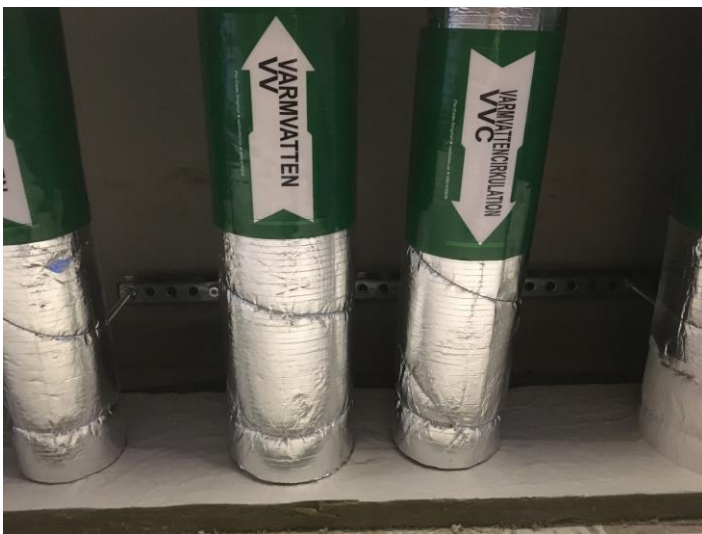
VV- och VVC-ledningar är inte samisolerade i höghusen.
