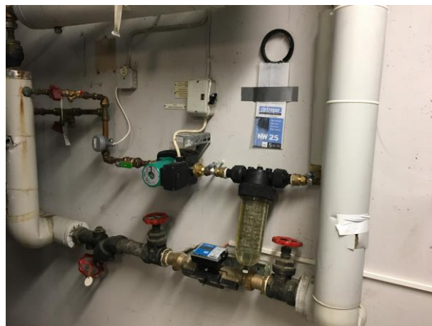
Åtgärder efter väteperoxidanläggning.
