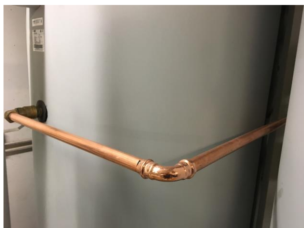
VVC-ledningen kopplades till varmvattenberedare efter fördjupningen.
