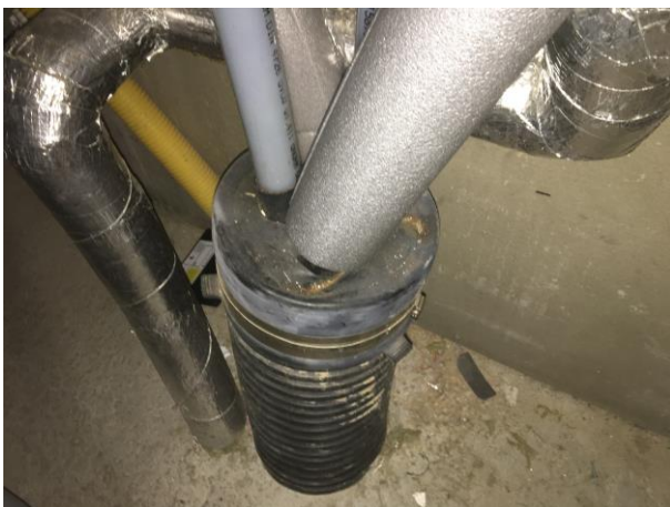
Nergående kulvert till husen.
