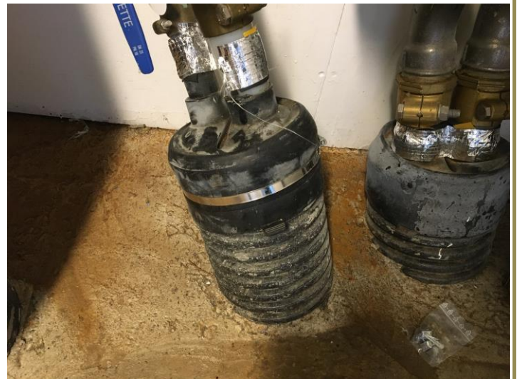
VV och VVC kommer upp i UC samisolerat.
