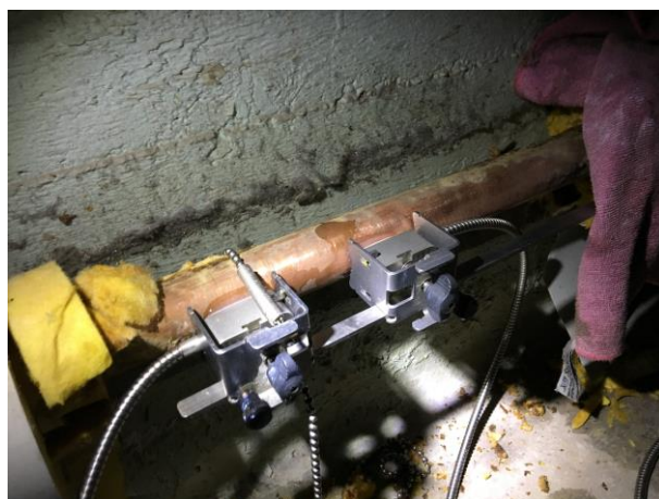
Flödesmätning i undercentral, huvudledning VVC
