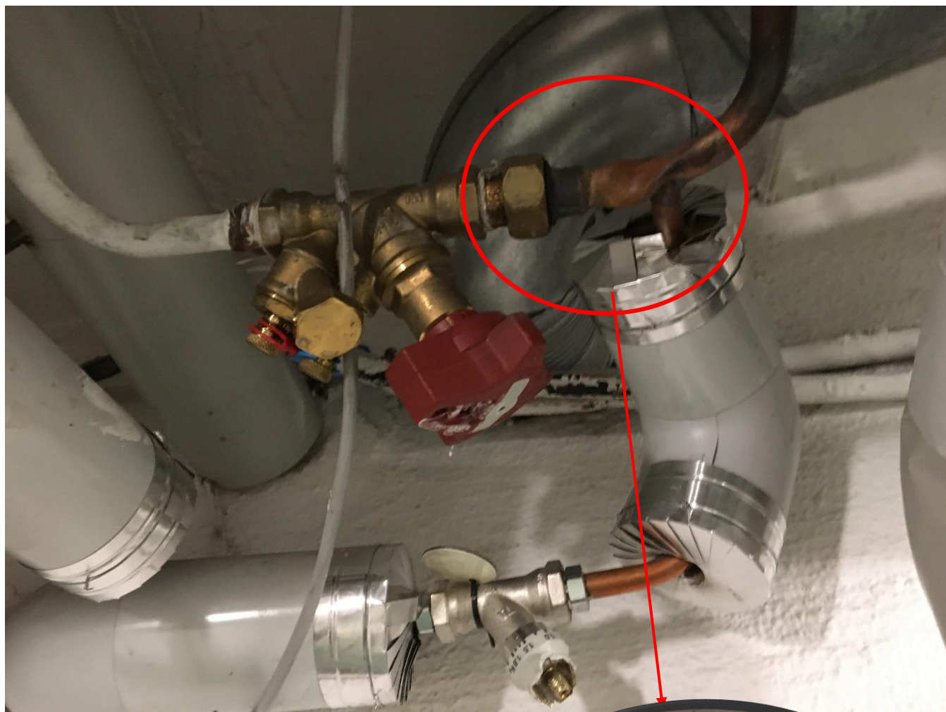
Figur 30 STAD-ventil och en STK-ventil Felaktigt installerad STAD-ventil. Utöver att det är inte tillräckligt med raksträcka framför och bakom STAD-ventilen är röret sammanpressat och ett insvetsat kopparrör nära ventilen leder till en TA-STK-ventil.
